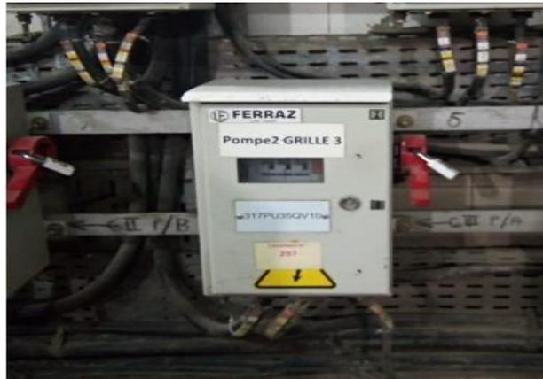
*Figure 2.7 L'interrupteur à coupure visible ICV.*
