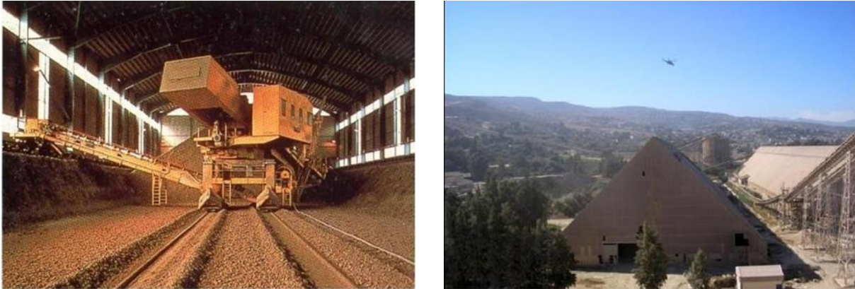
Figure I.8 : Pré homogénéisation et stockage des matières premières.
