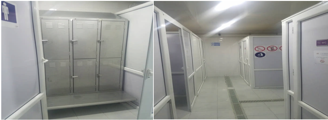
Figure 6 : Vestiaire avec armoires en inox
