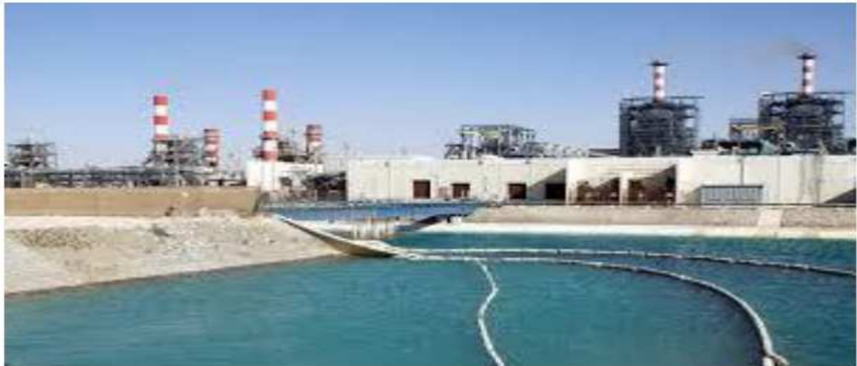
Figure 1.2 : Station de dessalement SEAAL, Fouka [1].
