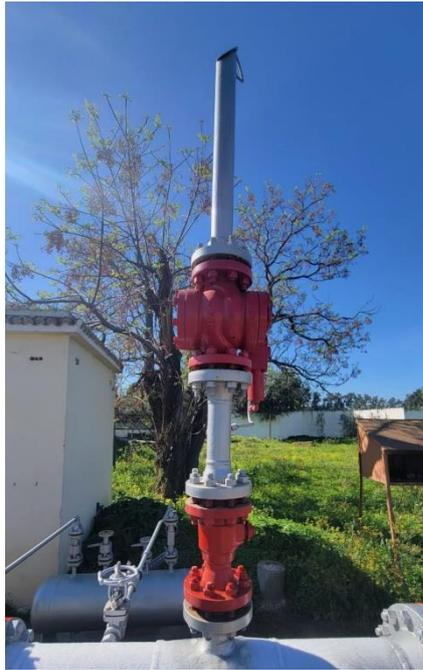
Figure (1.8) Soupapes de sécurité de détente chiffa
