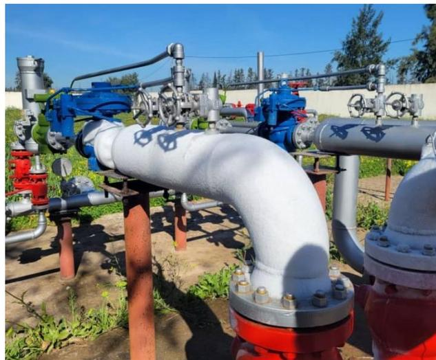
Figure (2.12) : Le givrage dans Le poste de détente gaz naturel
