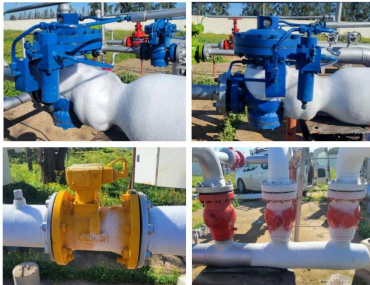
*Figure (2.11) Givrage du pilote du poste et de la partie aval de régulateur*
