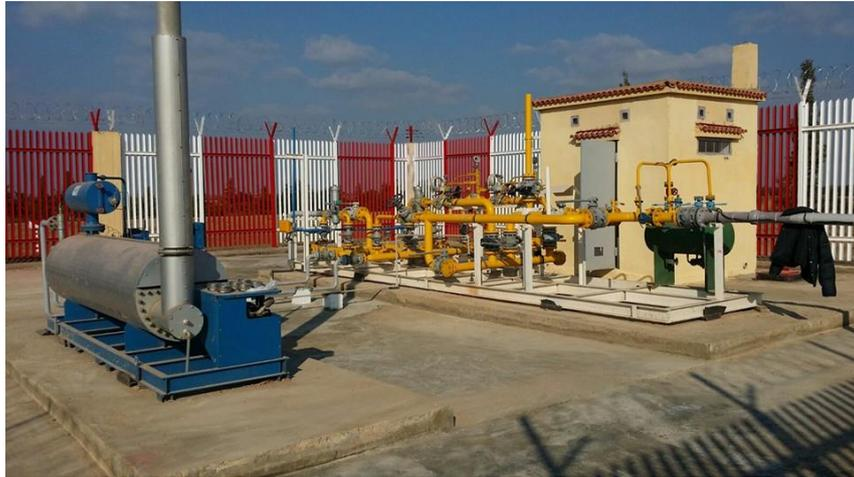
*Figure (1.3) Poste de détente gaz avec réchauffeur – BENI TALL*
