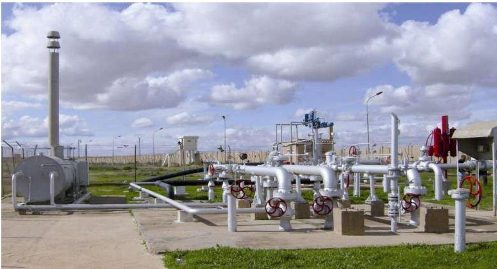
Figure (2.18): Réchauffeur raccordé avec poste détente [17].
