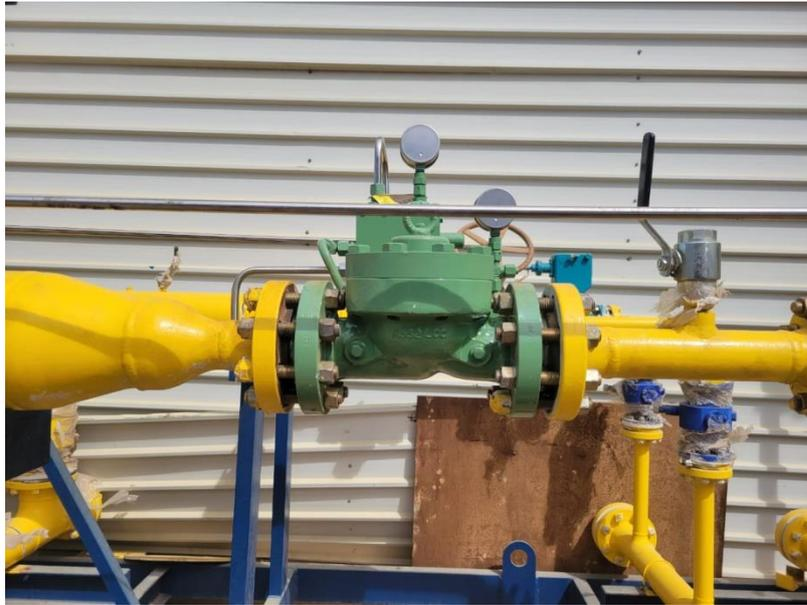
*Figure(1.6) Régulateurs de poste de détente en réalisation dans l'entreprise SASCOC*
