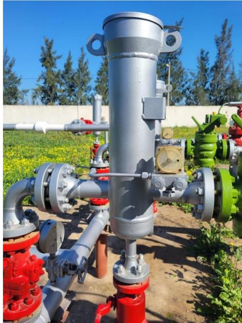
*Figure (1.5) Filtre à gaz de poste détente chiffa*
