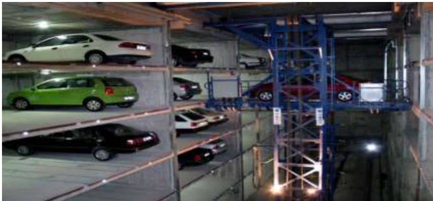
Figure 1.2: Système de stationnement de type empileur [5].
