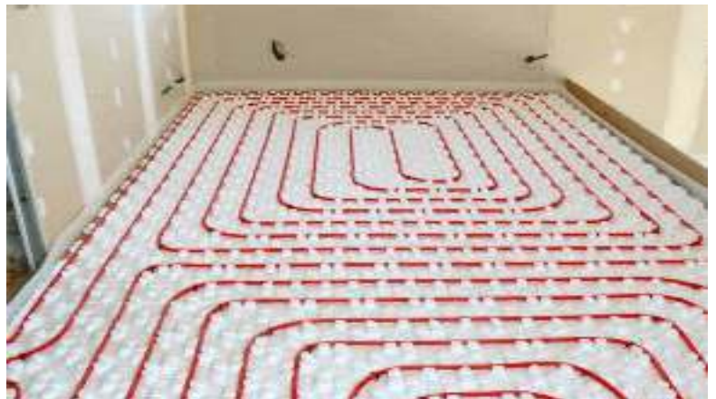
Figure1. 6. chauffage centrale par le sol[15]
