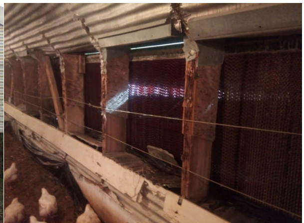
Figure10 : le Pad-cooling dans l'élevage étatique
