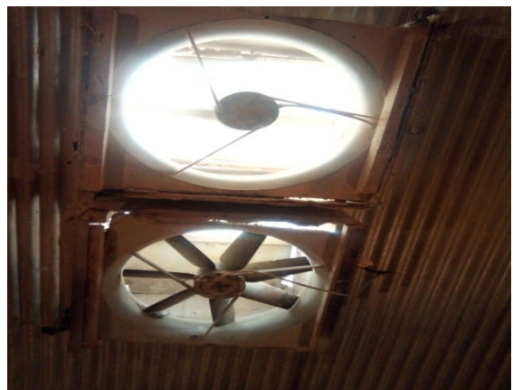
figure 6 : les extracteurs du plafond dans l'élevage étatique
