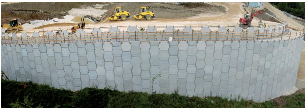
Figure 1. 31: Mur en terre armée.
