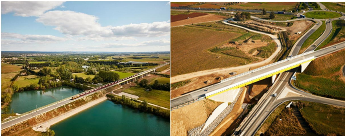
Figure 1. 1: Types de Remblai (ferroviaire, routier)
