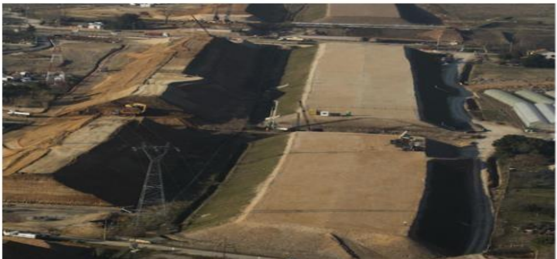
Figure 1. 3: Remblai de grande hauteur
