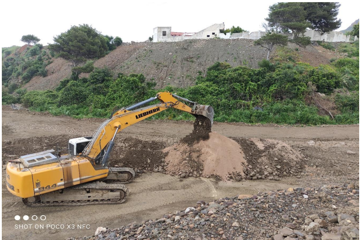
Figure 2. 10: photo illustrant le mélange de TVO + sable grossier.
