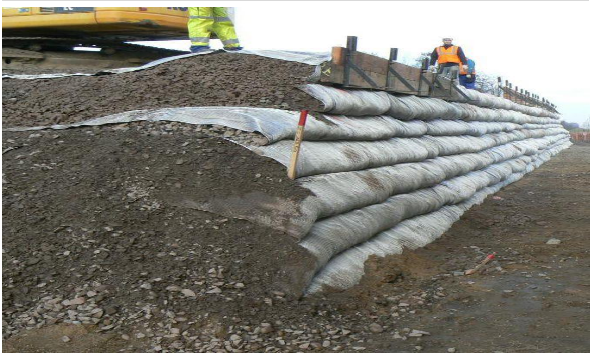
Figure 4. 1: mise en place des géotextiles de renforcement.
