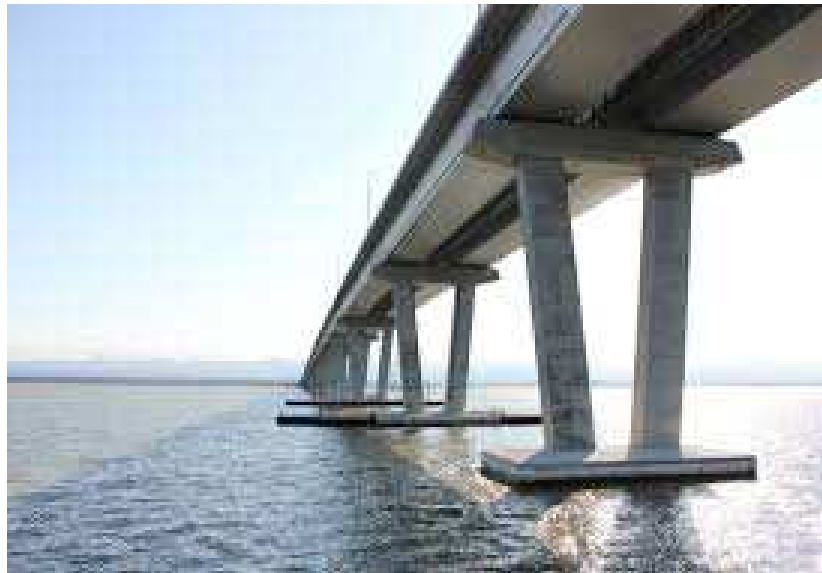
Figure I-14 : Pont réalisé avec un béton à hautes performances (BHP)
