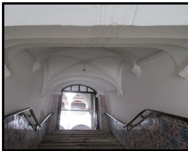
Fig.26.escalier menant vers le patio
