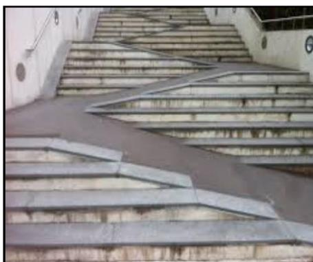
Figure: 35: rampe intégré avec escalier
