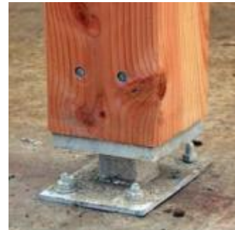
Figure 87: Pied de poteau en acier galvanisé, google image
