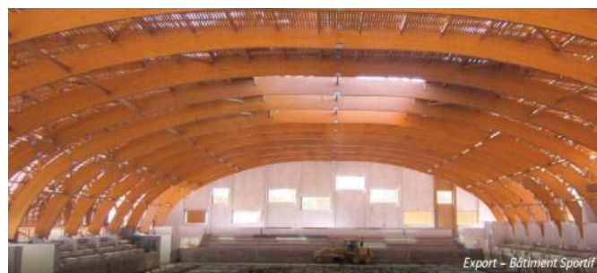
Figure 84: Système en arc, google image .
