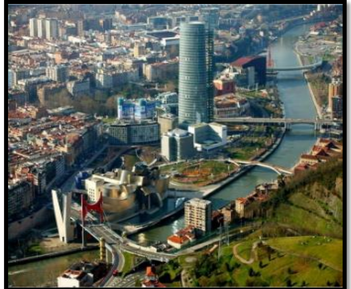
Construction d'une tour (bureau + deputation Source Bilbao Ria 2000
