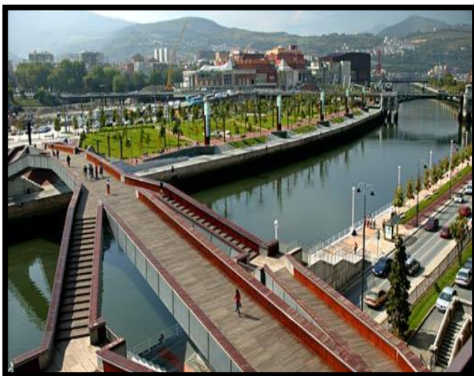
Pont de salve Source Bilbao Ria 2000
