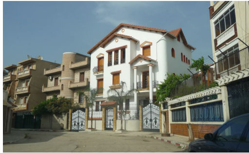
Figure 2.26. Cité Krim Belkacem à Dar El Beida. Source: Album des belles façade en Algérie, groupe Facebook
