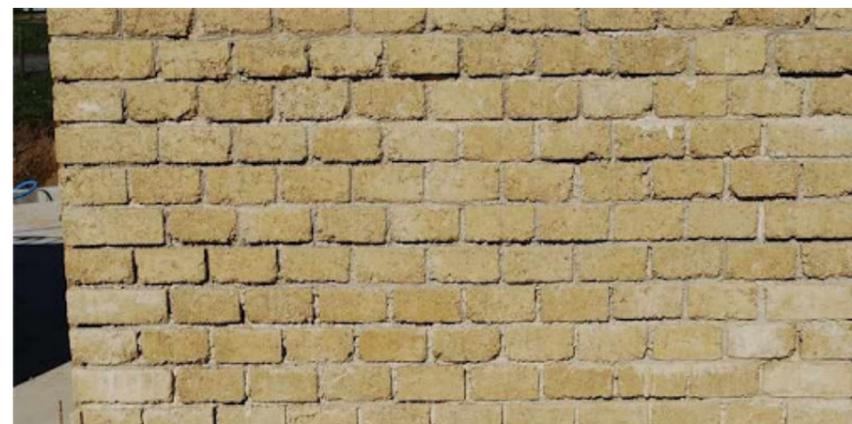
Figure 22. Mur en brique de terre cuite compressée. Source: Auteur
