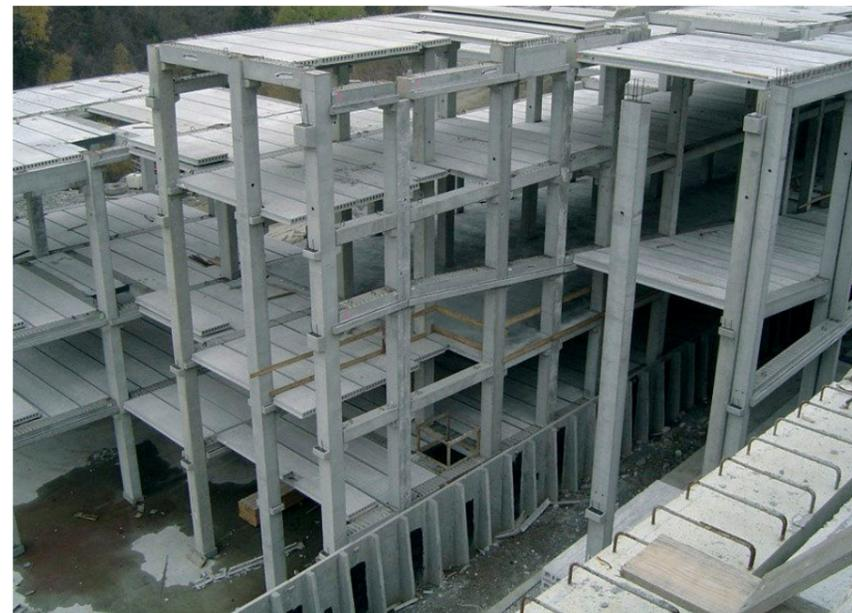
Figure 20. Système poteau poutre béton armé. Source: Auteur
