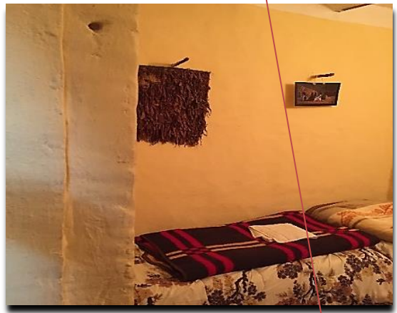
Fig77 : chambre 3 de RDC Source : auteurs 2018
