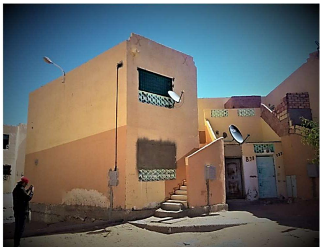
Fig5 : Habitat collectif à Ouargla Source auteurs 2018
