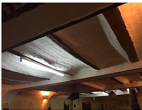
Fig82 : planche en voutains de plâtre Source : auteur 2018
