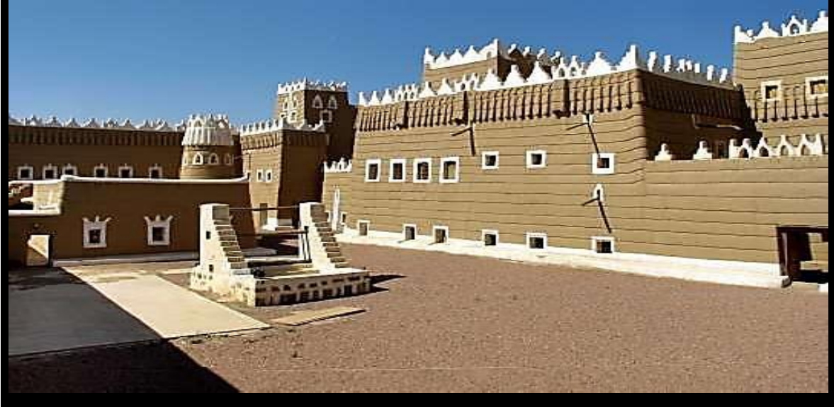
Fig6 : Bâtiment en bauge (Najran, Arabie S.)
