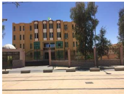
Fig46 :Équipement à Ouargla Source : Auteur 2018
