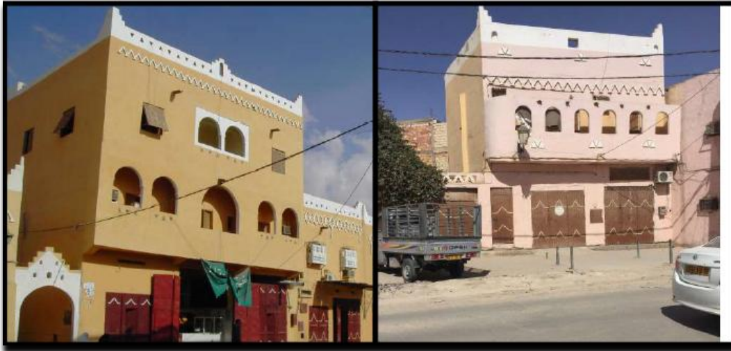
Fig 92 et 93 : Deux façades après la transformation
