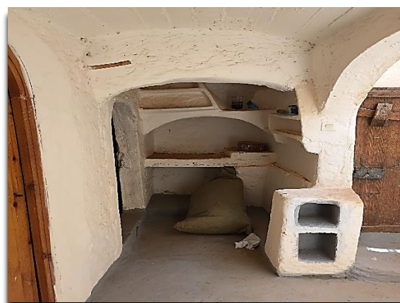
Fig83 : mur extérieur recouvert de plâtre blanc Source : auteur 2018
