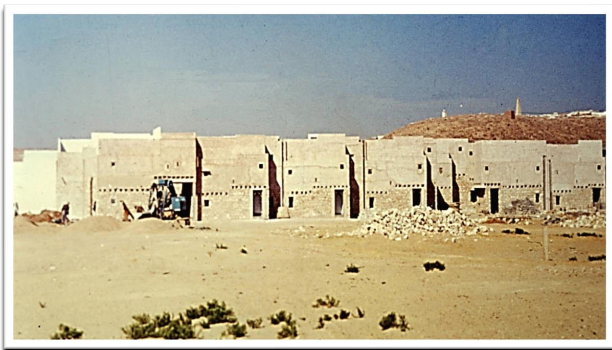
Fig63 : vue de façades extérieure de sidi abbaz
