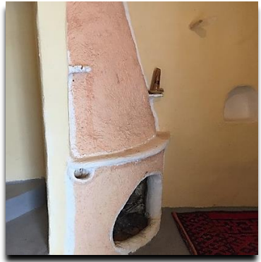
Fig 74 : cheminée de séjour Source : auteurs 2018
