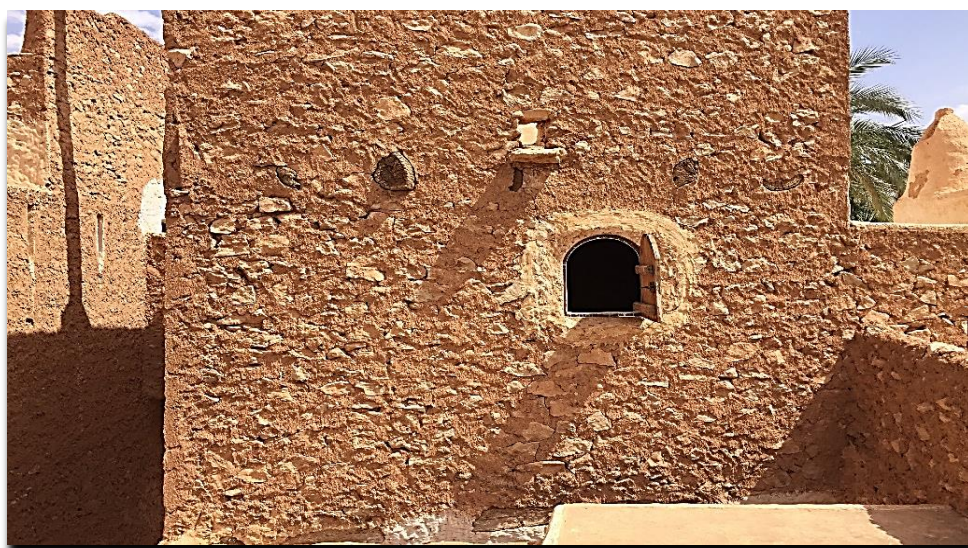
Fig81 : mur extérieur en pierre d'une maison Source : auteur 2018
