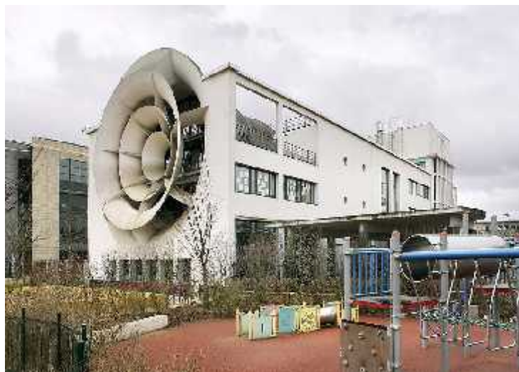
Photo 07 : La soufflerie d'Hispano-Suiza à Bois-Colombes reconvertie en école primaire par les architectes Patrice Novarina et Alain Béreau
