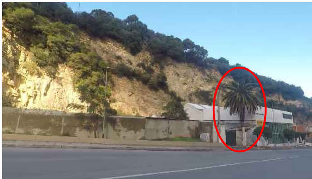
Photo 30 : Préservation de la nature Source : Auteur
