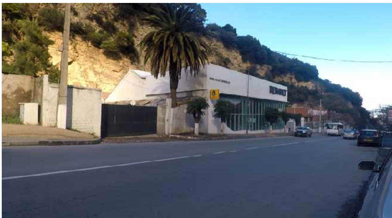
Figure. 27 : Bâtiment de Renault avec l'extension Source : Auteur
