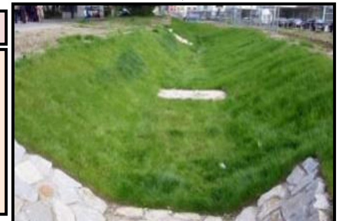
Figure 30: les fossés. Source : lesaïrelles, 2005.
