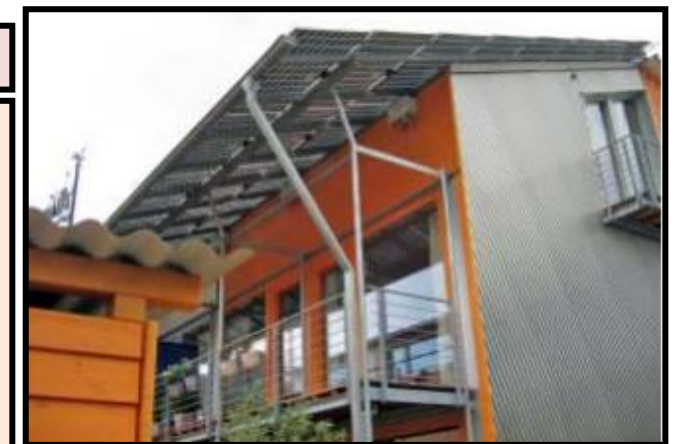
Figure 29: les panneaux photovoltaïques. Source: lesaïrelles, 2005.
