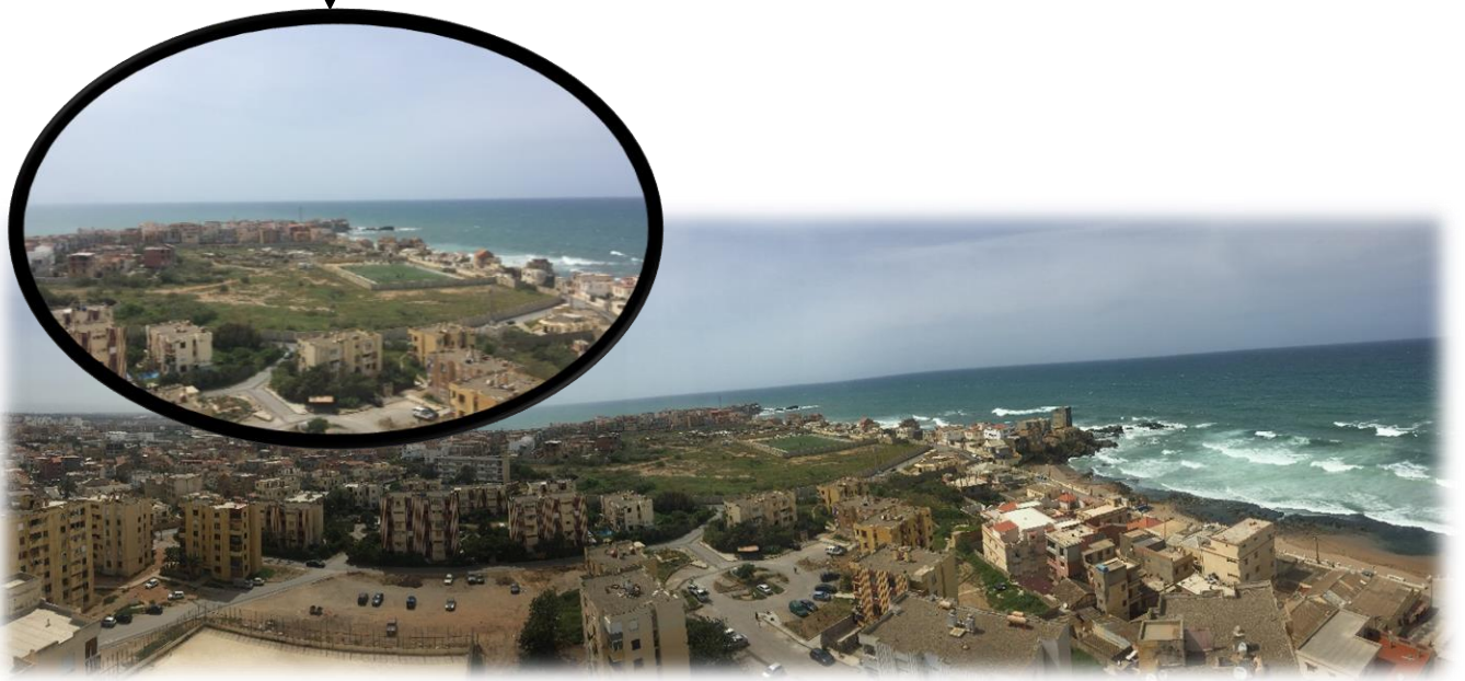
Figure 19 : Vue sur le site d'intervention Source : Auteurs
