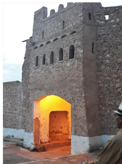
Fig01 : une des portes du Ksar TINEMMIRINE. Source : auteurs-Mai 2018
