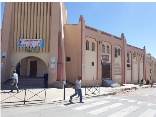
Fig 46 : façades de constructions sur une voie principale à Ouargla Source : Auteurs-Mai 2018
