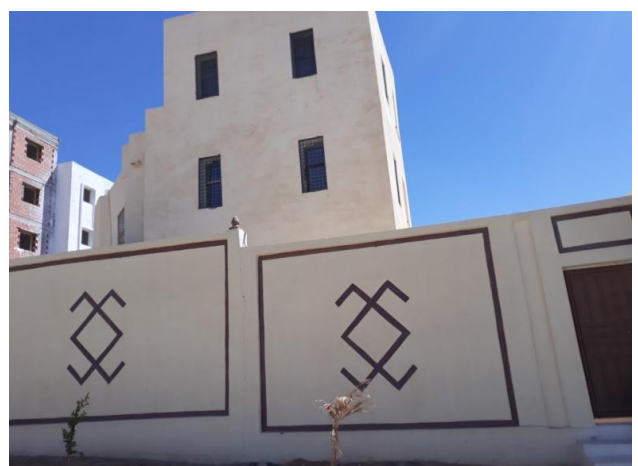
Fig 47 : dessins sur un mur d'une construction à Ouargla Source : Auteurs-Mai 2018
