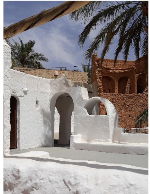
Fig 33 : murs extérieurs en pierre de l'espace extérieur recouvert de plâtre blanc Source : Auteurs-Mai 2018
