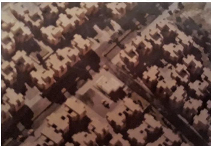
Fig17 : vue aérienne des logements sociaux à EL OUED
