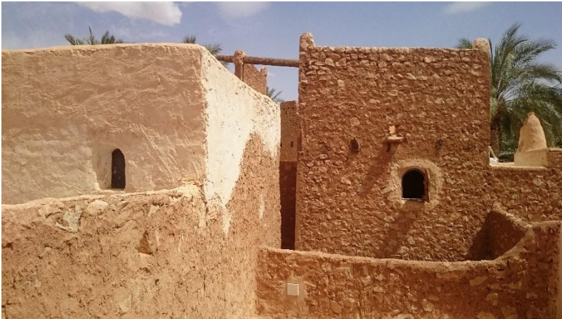
Fig 32 : murs extérieurs en pierre d'une maison à deux niveaux Source : Auteurs-Mai 2018
