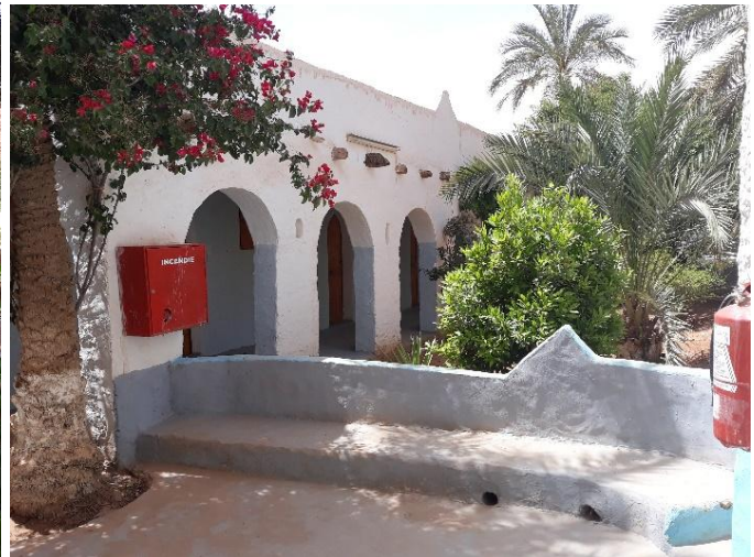
Fig 23 : Espace de regroupement extérieur Source : auteurs- Mai 2018
