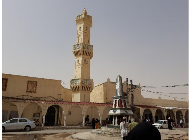
Fig77 : la mosquée de Sidi Baafou à l'état actuel Source : auteurs-Mai 2018
