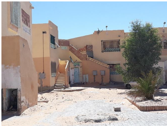
Fig 56 : murs construits ou élevés cachant les accès aux logements Source : Auteurs-Mai 2018
