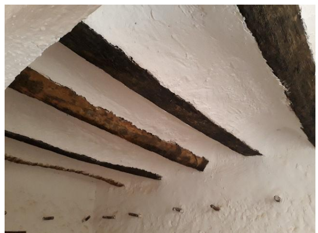
Fig 35 : plancher traditionnel en voutains de plâtre Source : Auteurs-Mai 2018
