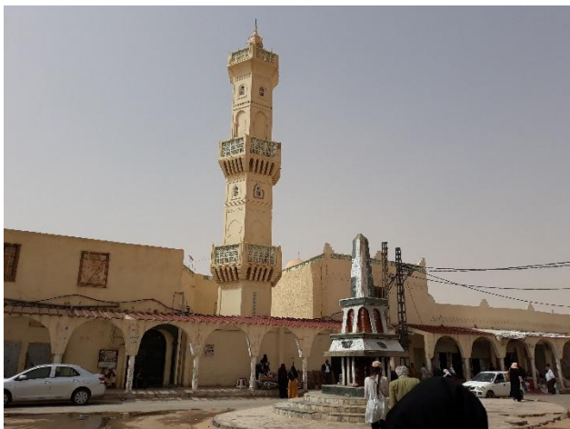
Fig88 : la mosquée Sidi Baafou au ksar de Ouargla Source : auteurs-Mai 2018
