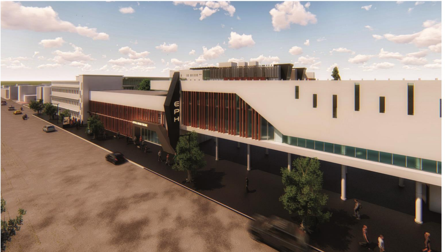
VUE SUR LA FAÇADE PRINCIPALE
