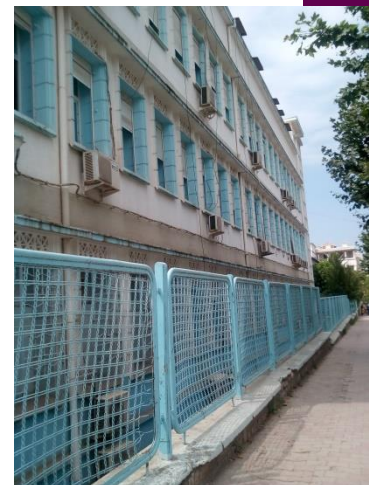
Figure 49: Photo hôpital Brahim Trichine-vue de l'extérieur- (Auteur)
