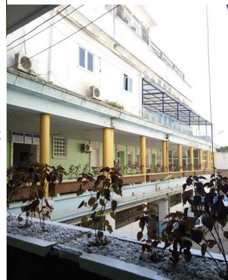
Figure 101: Vue sur le corridor coté Laboratoire
