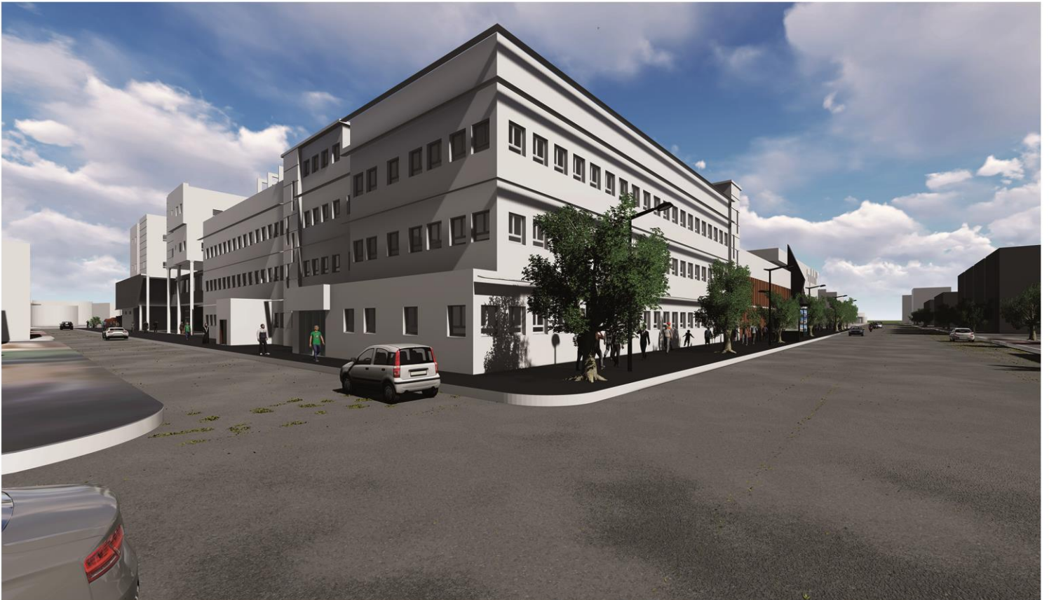
VUE ANCIEN ET NOUVEAU BATIMENTS
