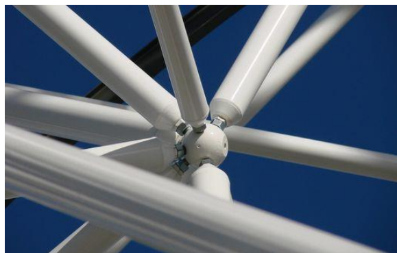
Figure 146 : Structure tridimensionnelle tubulaire. Source : https://www.lemoniteur.fr
