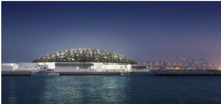
Figure 95 : Photo sur le musée du Louvre Abu Dhabi. Source www.archdaily.com
