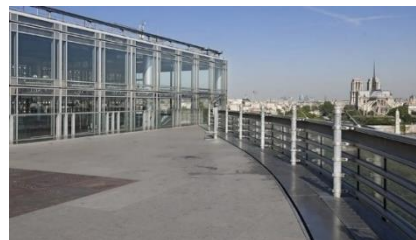
Figure 129 : Terrasse du IMA Source : https://www.imarabe.org/
