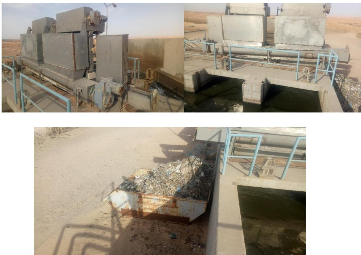
**Figure III 4 : dégrilleur automatique**
