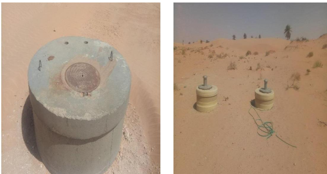
Figure III.14. des regards dans la longueur de canal de transfert pour l'aération et les prelevement
