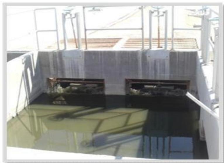
**Figure III 11: Ouvrage de répartition.**
