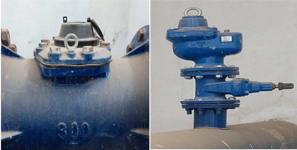
**Figure 3.10 : Compteur hydraulique et la ventouse d'air**
