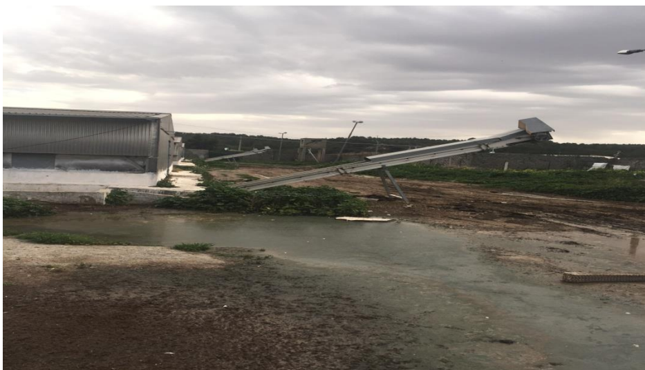
Figure 12 : Système d'évacuation des fientes (photo personnelle)
