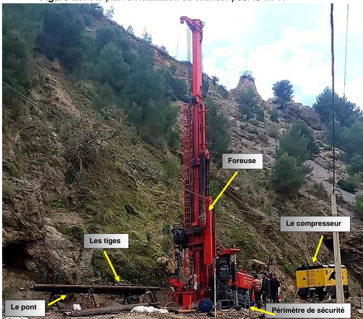
Figure III.2 : installation du chantier pour le MFT.
