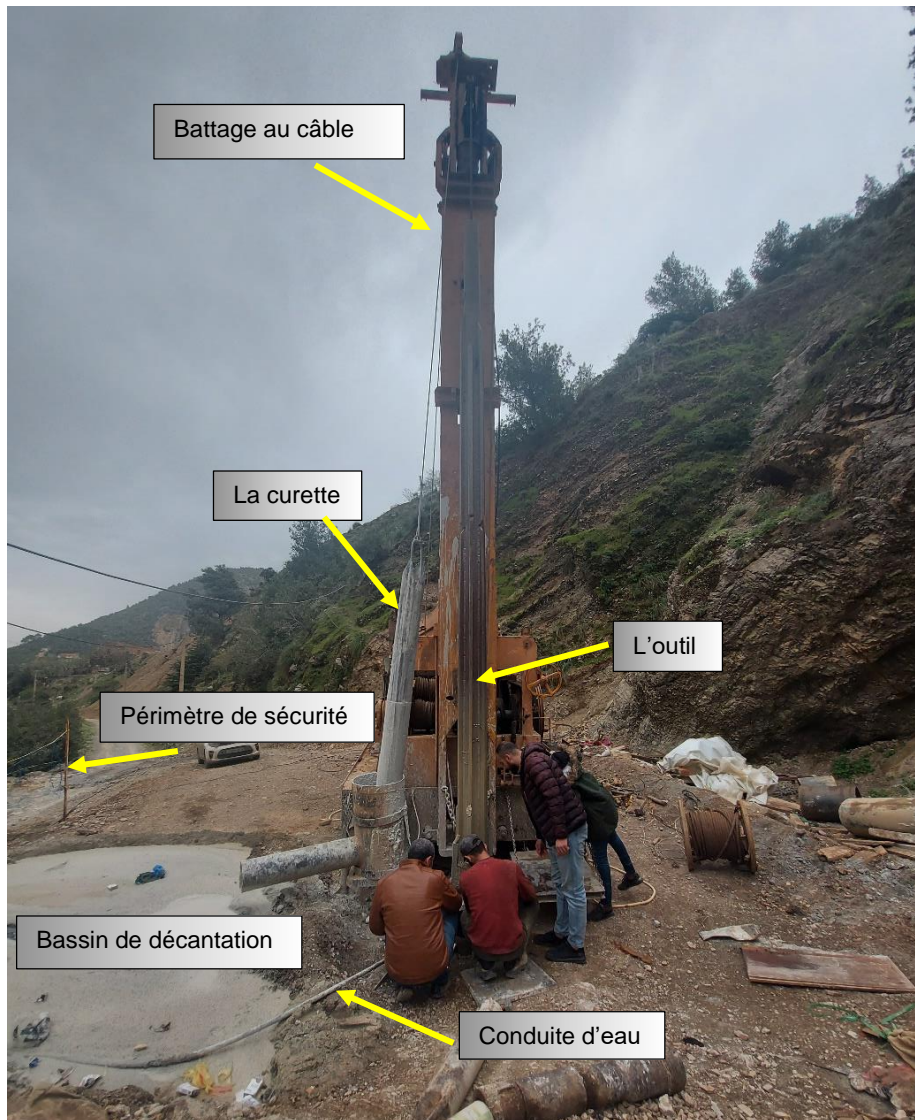
Figure III.13 :L'installation du chantier pour le battage.
