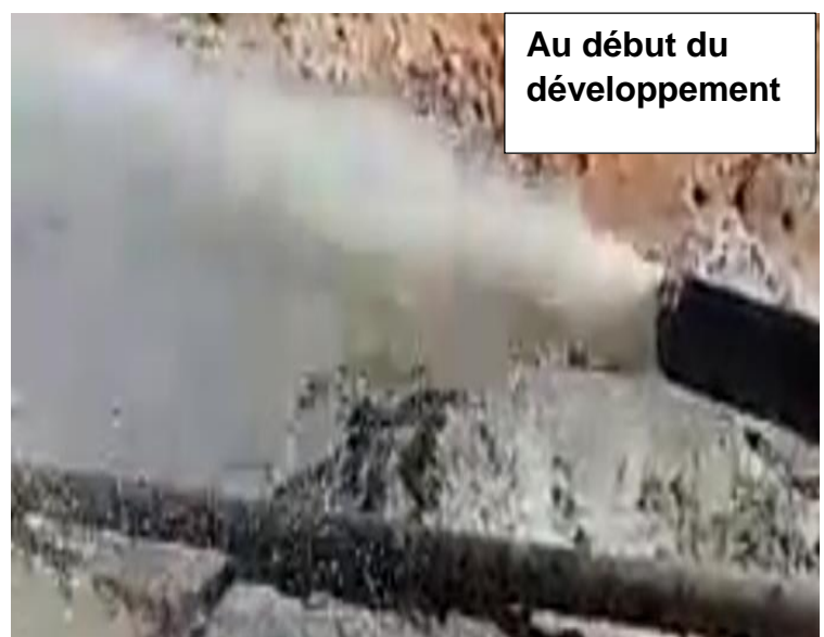
Figure III.18 : Développement à l'air lift
