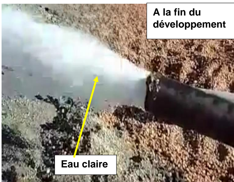
Figure III.18 : Développement à l'air lift
