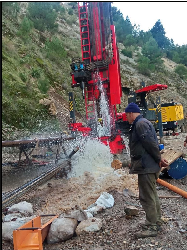
Figure III.9 : essai à blanc au compresseur
