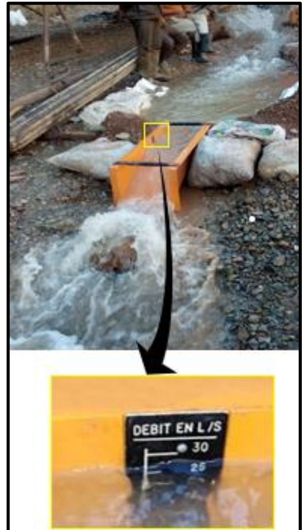
Figure III.10 : Le débit mesuré à l'aide d'un déversoir est de 25 l/s.
