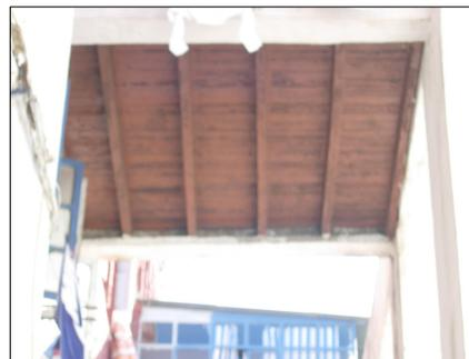
Fig 3.6 : Vue sur les planchers en bois, "Climat de France" (Algérie), F.Pouillon architecte, 1955. [15]
