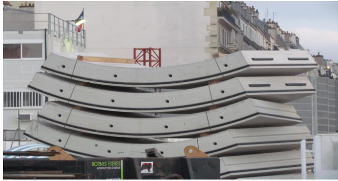
Figure II.3: Exemple des voussoirs préfabriqués.
