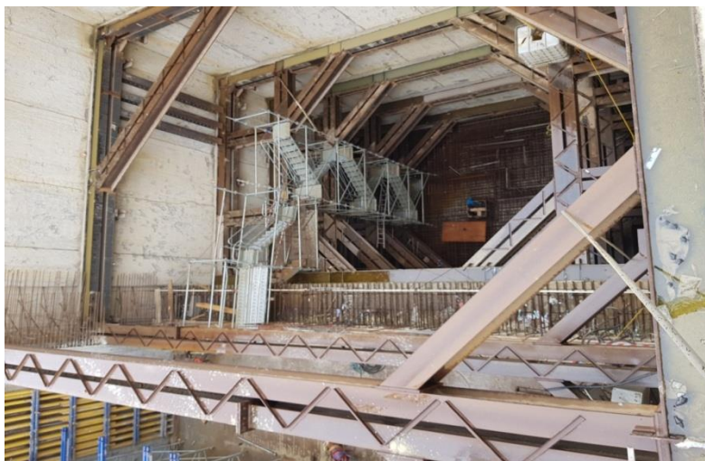
Figure I.6 : Exécution du puits de ventilation PV6– Extension E de la ligne 1 du métro d'Alger, (Photo prise le 25 mars 2019 par les auteurs).
