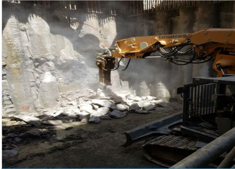
Figure I.7 : Attaque du rameau de connexion à partir du puits de ventilation PV6 (photo prise le 25 février 2019 par les auteurs).
