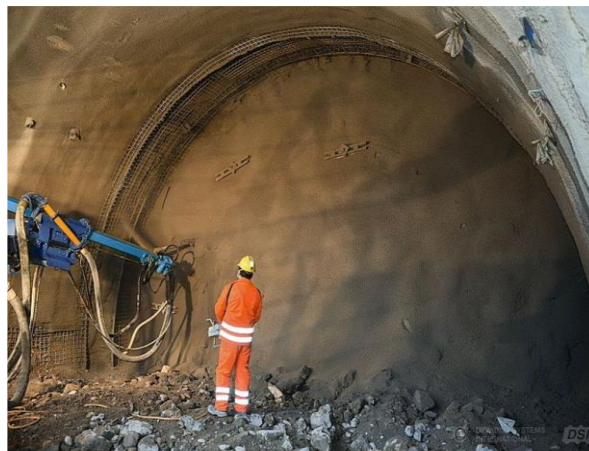
Figure II.1: Mise en place du béton projeté (photo du métro d'Alger).
