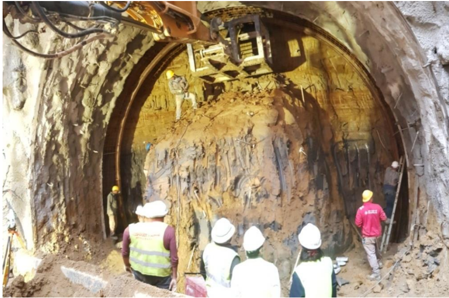
Figure I.9: Mise en place du treillis soudé entre les cintres métalliques (photo prise le 25 février 2019 par les auteurs).
