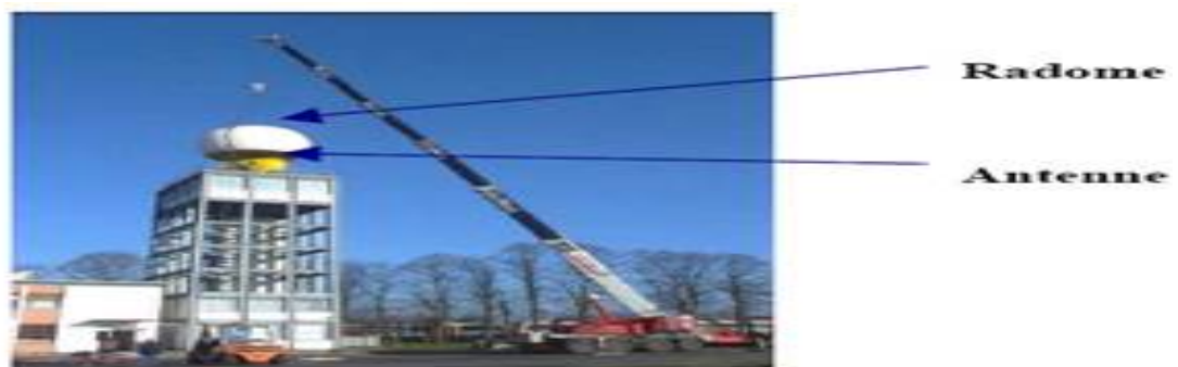
Figure 2.1 : installation d'un radar
