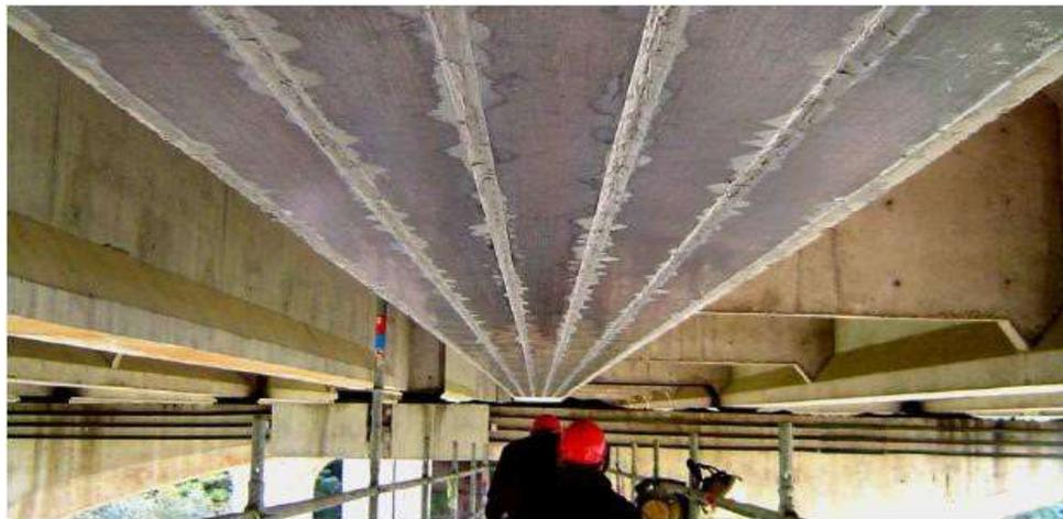
Figure I.7. Application de la technique des tôles collées
