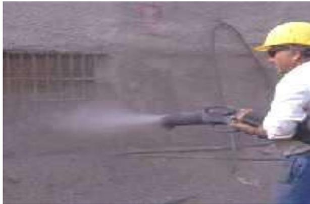
Figure I.5 Technique de projection du béton
