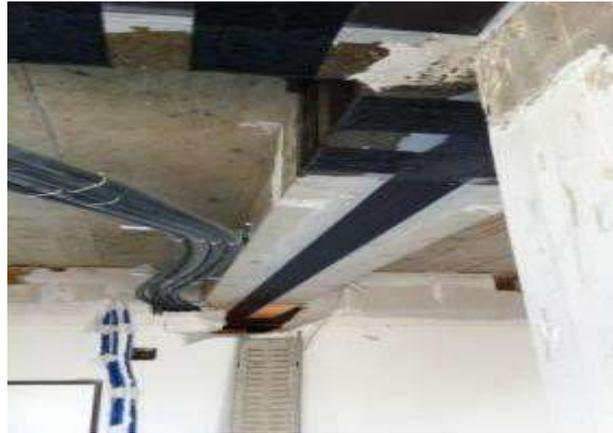
Figure II.7 Poutre renforcées par matériaux composites
