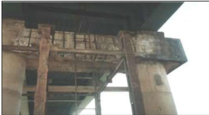
Figure I.4 Dégradation du chevêtre d'un pont en béton
