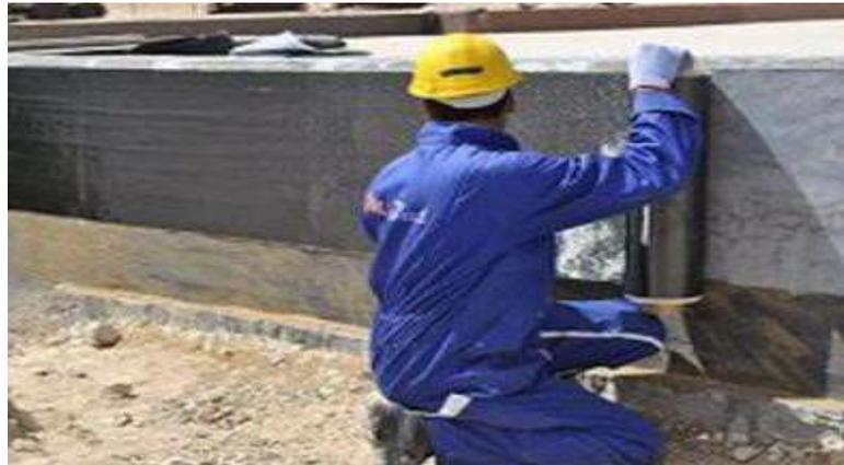
Figure II. 9 Mur en béton renforcé par CFRP
