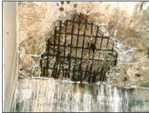
Figures I.3 Vue de la corrosion des armatures d'un tablier de pont
