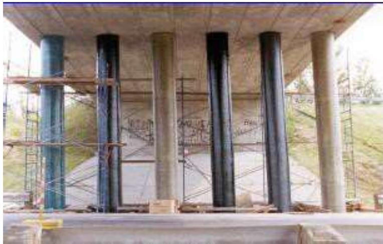
Figure I.9 Pile de pont renforcée par composites CFRP
