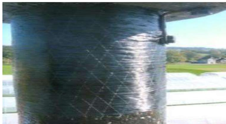
Figure II.6 Poteau circulaire en BA confiné par composites
