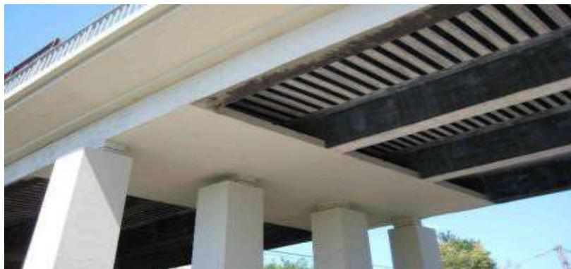
Figure II.8 Dalle de tablier de pont renforcée
