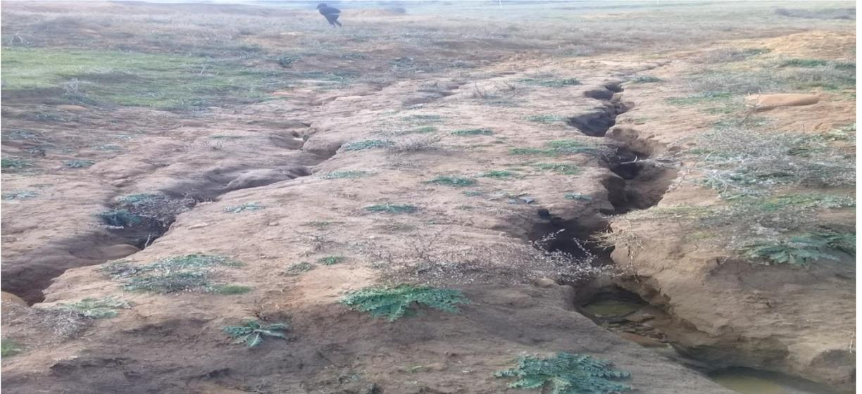
**Figure II:4 Fissures ouvertes au cœur du talus de déblai, laissant les eaux s'infiltrer et développant ainsi des pressions interstitielles nuisible à la stabilité générale. [18 ]**
