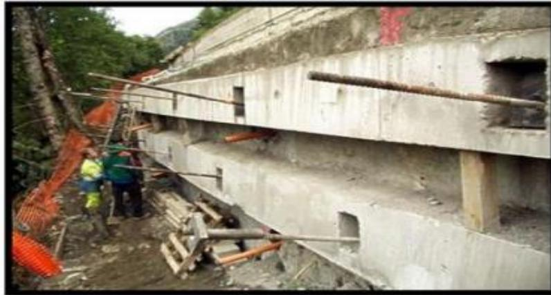
**Figure I:16 Exemple de tirants d'ancrage**
