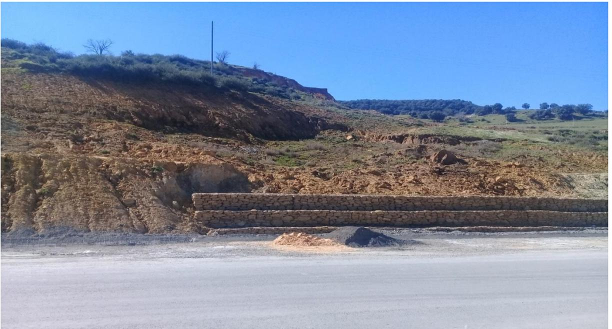
**Figure II:5 Talus de déblai caractérisé par des érosions intenses, avec déformation des gabions par endroit. [18]**
