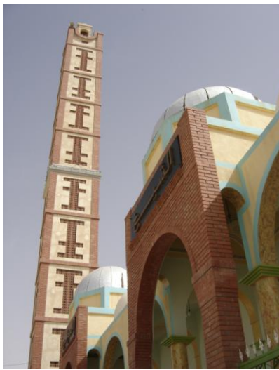
Fig. 3.28 : Le minaret et l'entrée de la mosquée El-Adouani après sa récente extension. Photo de l'auteur (2005)
