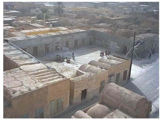
Fig. 3.35 : Vue sur le caravansérail et Bab El Guebli (Porte du Sud) avant sa démolition (2003). Photo de l'auteur
