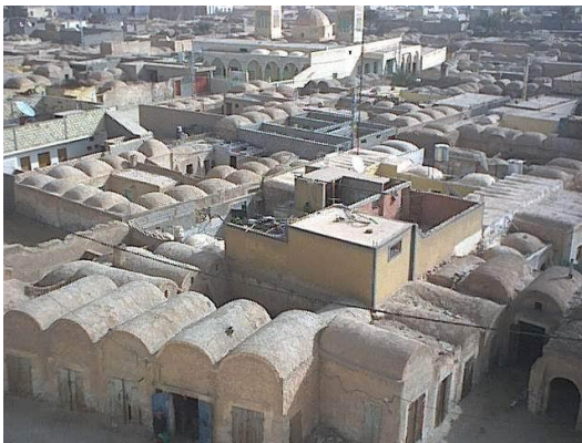
Fig. 3.34 : Vue sur le noyau initial et la mosquée Sidi-Messaoud au fond de la photo. Photo de l'auteur
