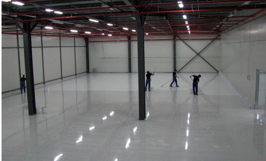
Figure II. 2: Pose peinture en résine époxy sur sol en béton
