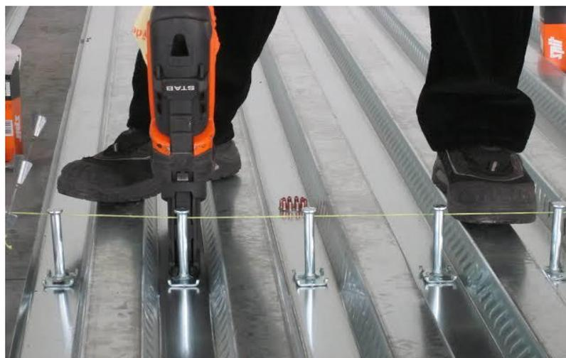
Figure I. 4: connecteur type goujon soudée.
