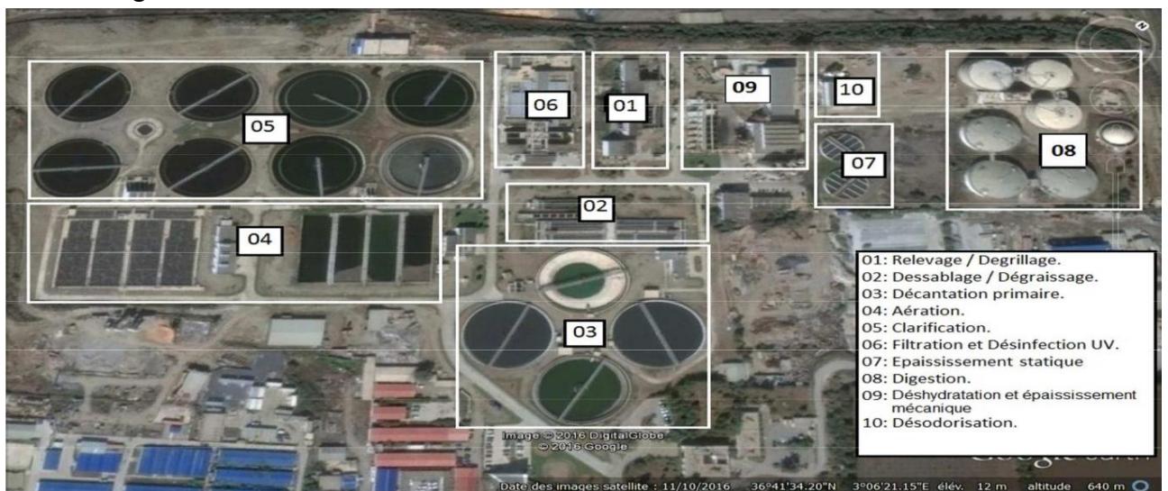
Figure. 6 : Station d'épuration de Baraki (SEAAL, 2016)
