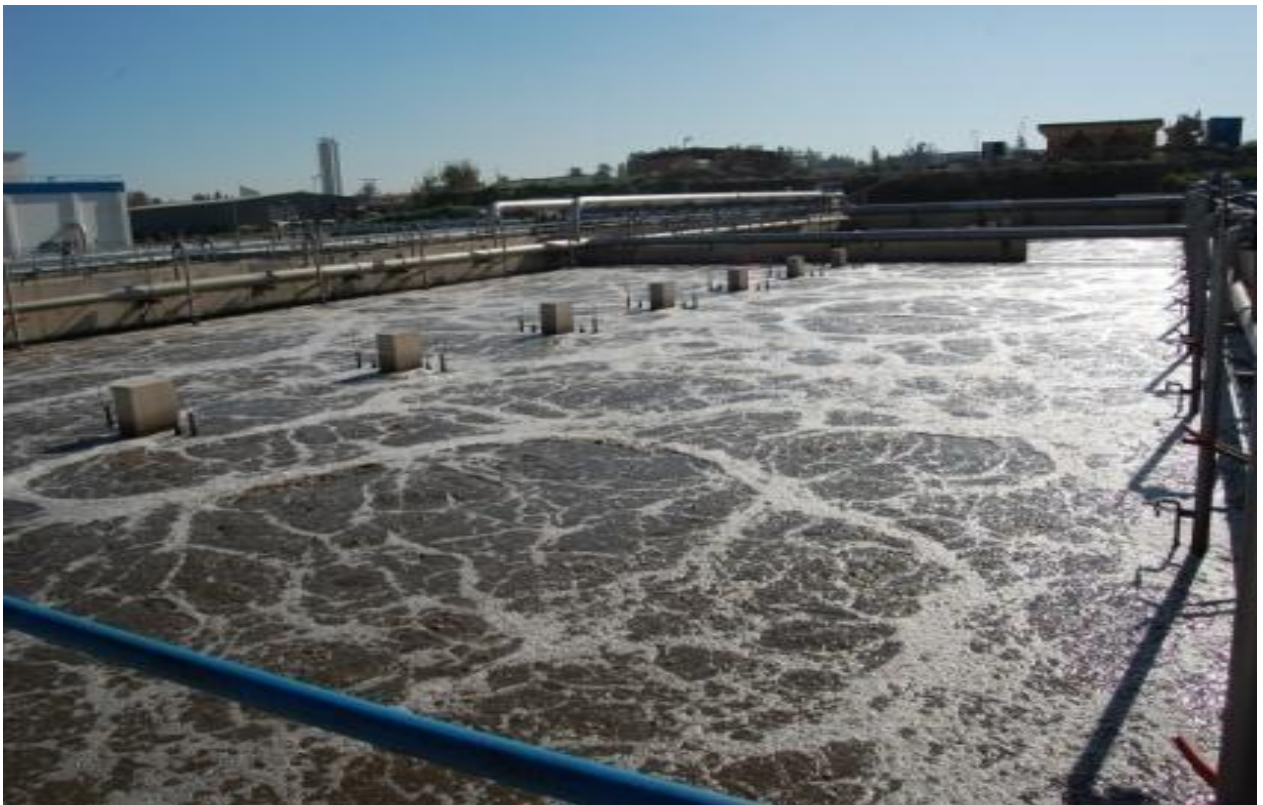
Figure.26 : Bassin d'aération
