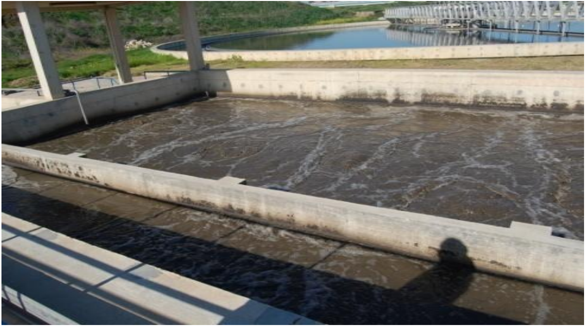
Figure. 27 : Bassin de dégazage
