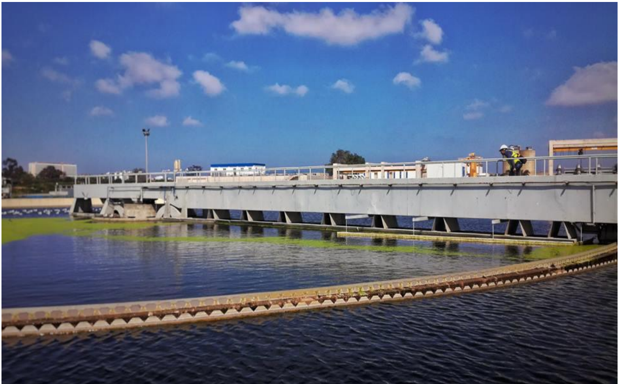
Figure.28 : Clarificateur
