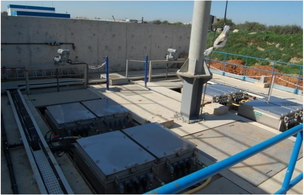
Figure.29 : Les modules de désinfection UV
