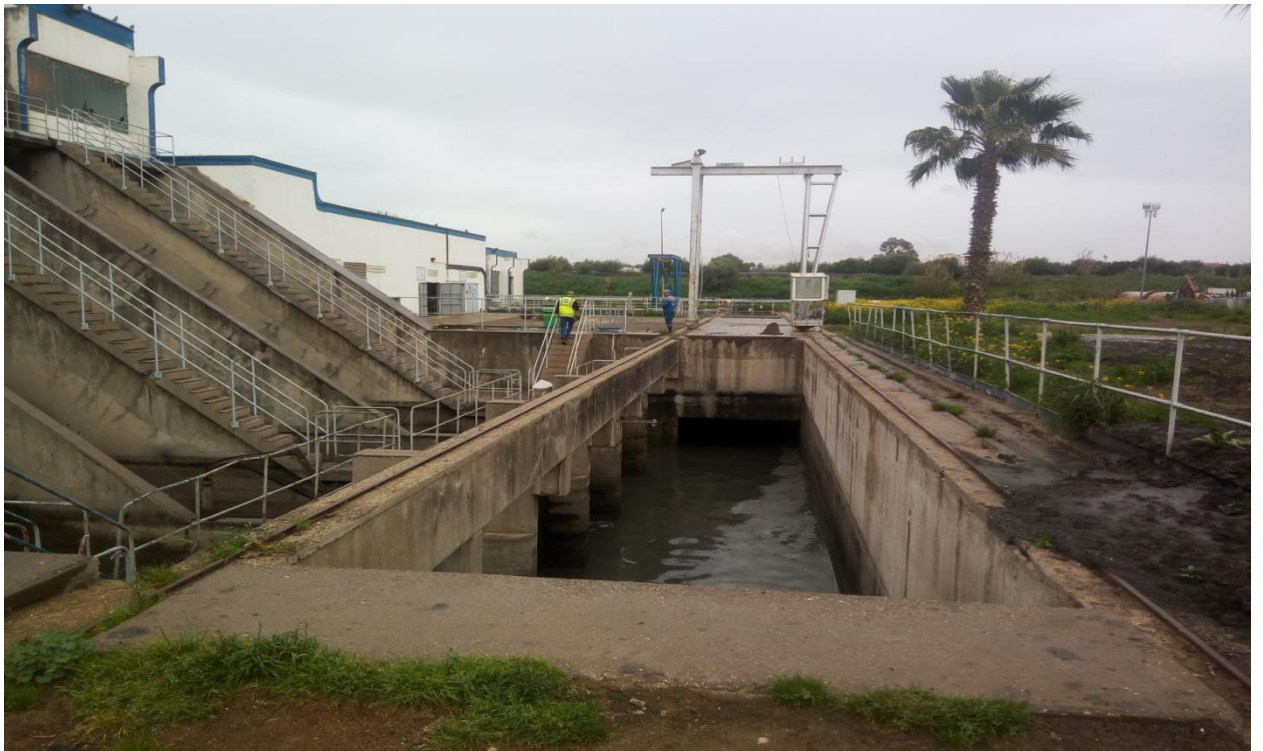
Figure.19 : Poste de relevage des eaux usées
