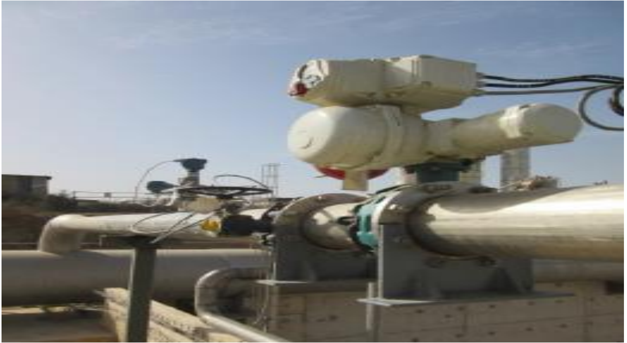
Figure.25 : Alimentation en air d'une zone du bassin biologique
