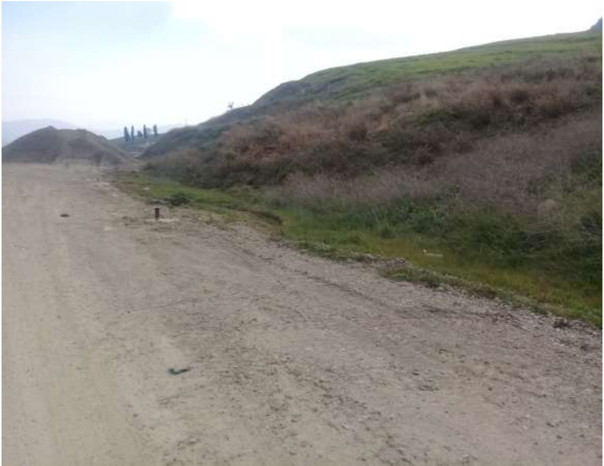
Figure II.5 : Vue générale du glissement [29].
