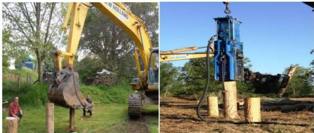
Figure I.16 : Pieux en bois [26].
