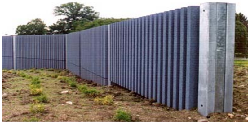
Fig. I.8: Mur antibruit à profil ondulé
