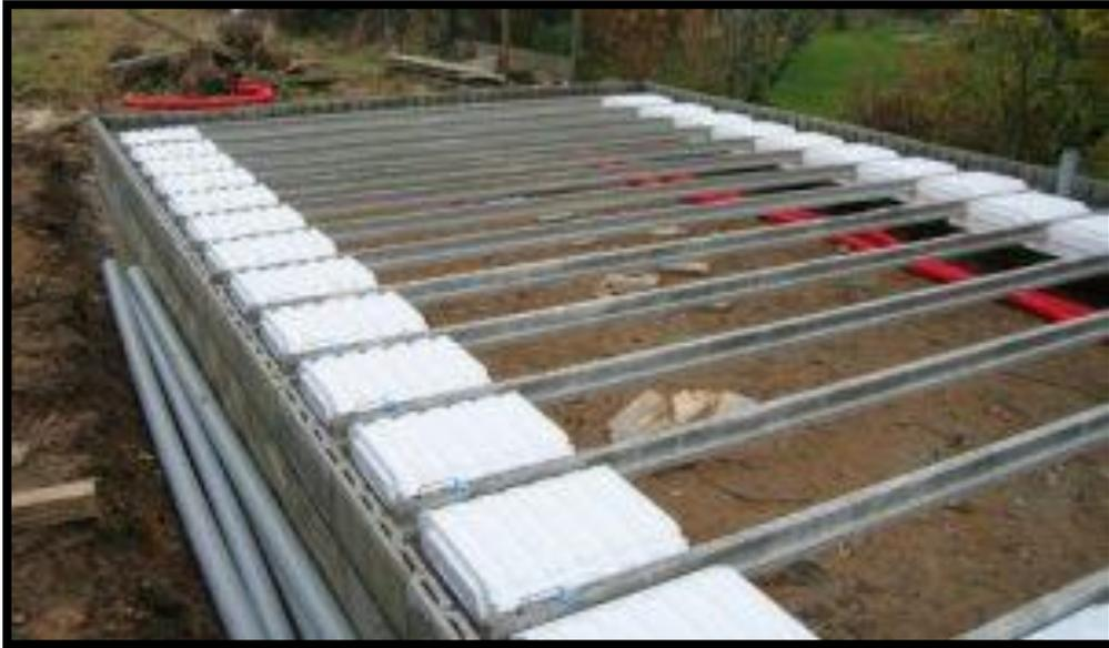
**Figure 21:Pose de hourdis en polystyrène (24)**
