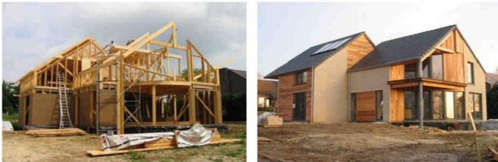
Figures (I.9) : Exemple d'une maison basse-énergie (K27)
