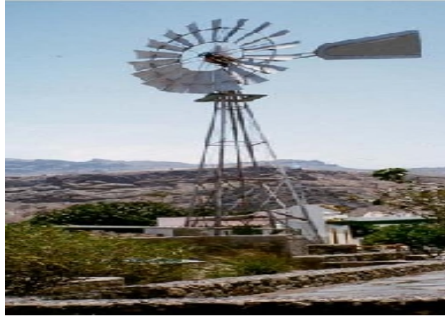
FIGURE 1.9 : MOULINS DE POMPAGE
