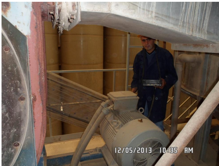
Photo 4-1 installation du matériel sur la machine
