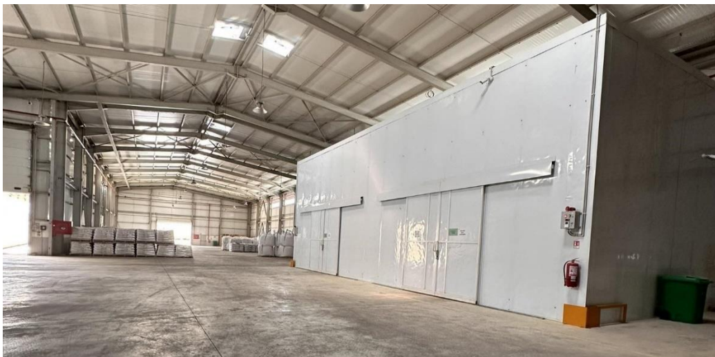
Figure 21. Zone de stockage MP (réalisée par l'étudiante)
