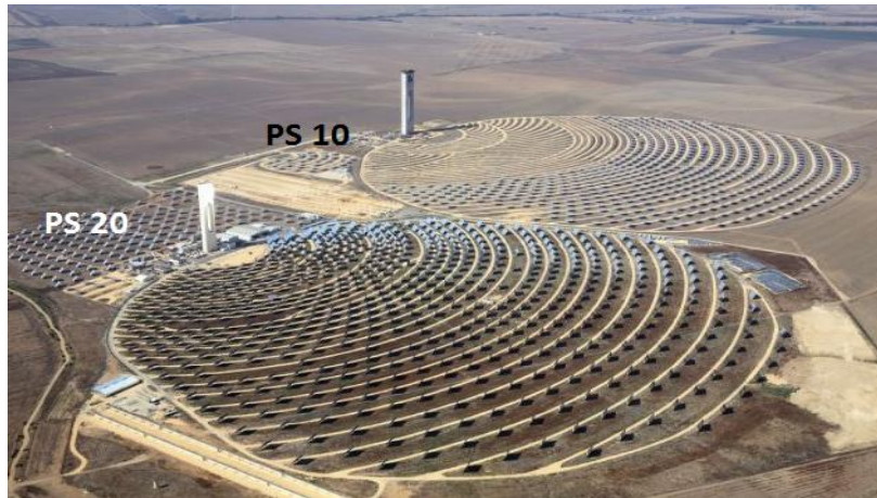
Figure 2.14. Photo réelle de la PS20 et PS 10 [17].
