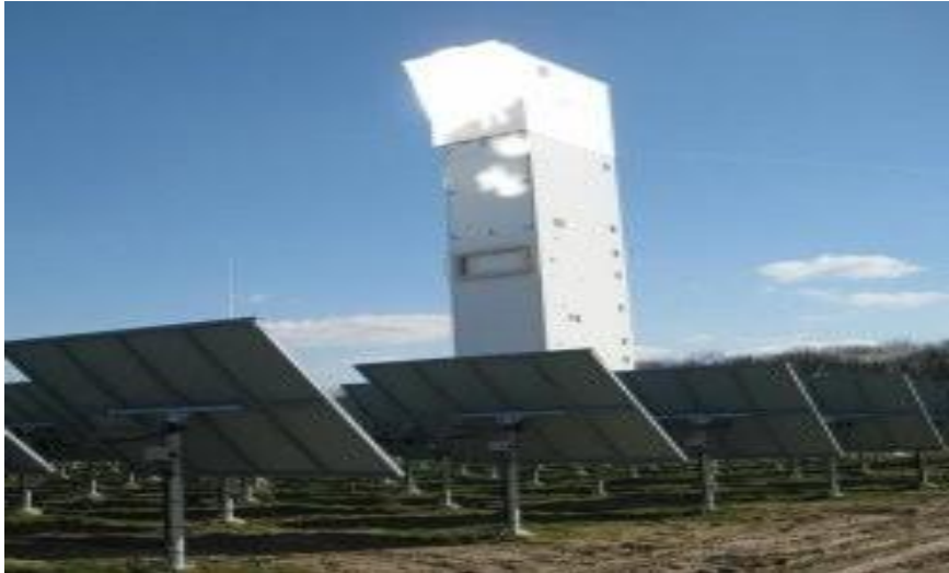
Figure 2.15. Une photo réelle de la centrale de Julich [17].
