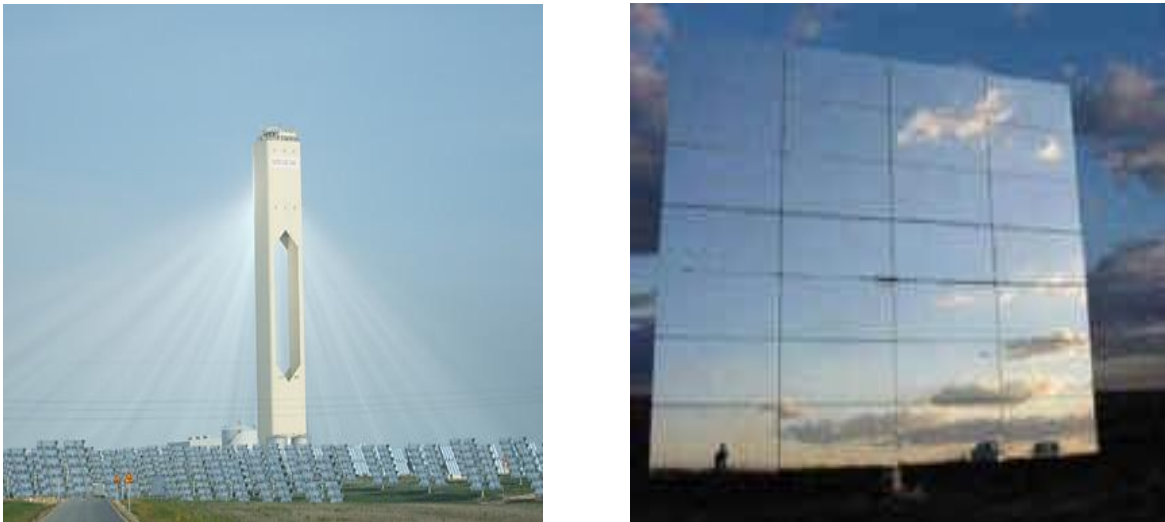
Figure 2.13. La figure à droite représente une photo réelle centrale PS10, celle à gauche représente une photo d'un héliostat [16].
