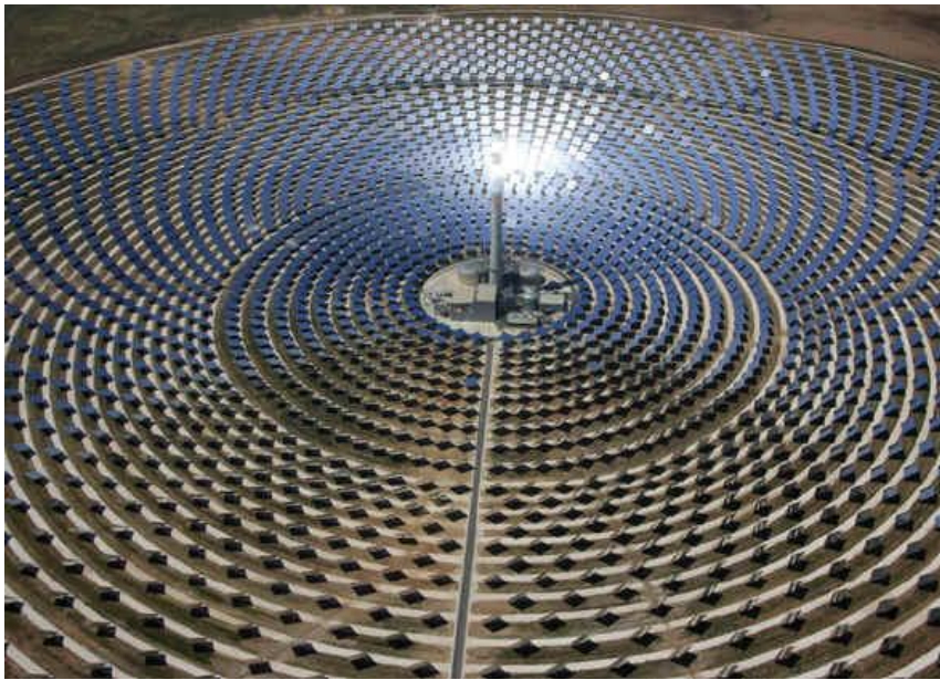
Figure 2.17. Photo réelle de centrale solaire GEMASOLAR [16]
