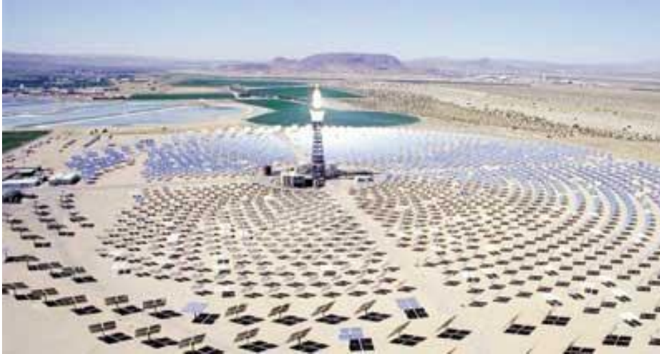
Figure 2.12. Photo réelle de centrale SOLAR 2 [16].
