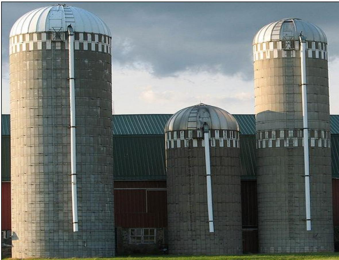
Figure I.8 Silos en bois debout béton
