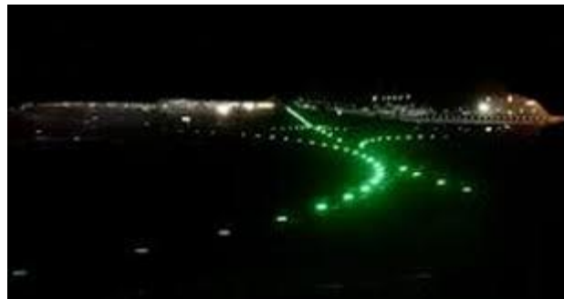
Figure I-15 : Feux d'axe de voie de circulation [19]
