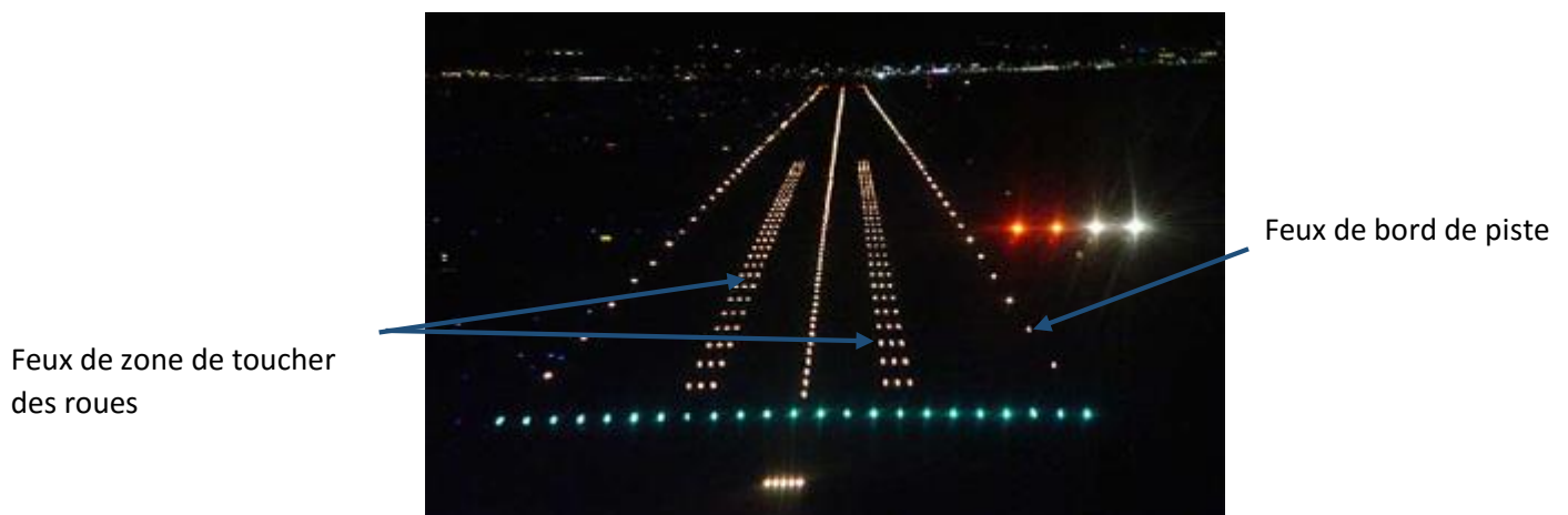
Figure I-14 : Feux de bord de piste et de zone de toucher des roues [19]
