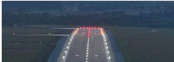
Figure I-13 : Feux d'extrémité de piste [19]
