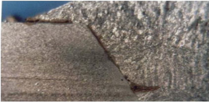
Figure II. 1 : Manque de fusion en bord de chanfrein et sous cordon.[14]
