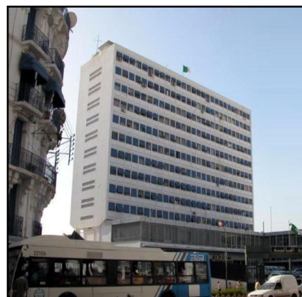
FIG III.40 : Immeuble Mauritania, place du Pérou
