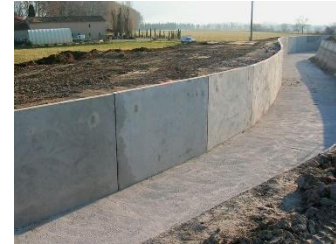
FIG III.59 : mur de soutènement Source : Google Images
