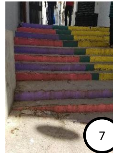
FIG III.16 : escaliers menant vers le marché Source : photo prise par les auteurs2018
