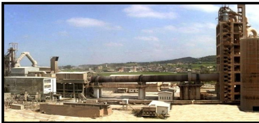
Figure I.8. Ligne de cuisson d'une cimenterie
